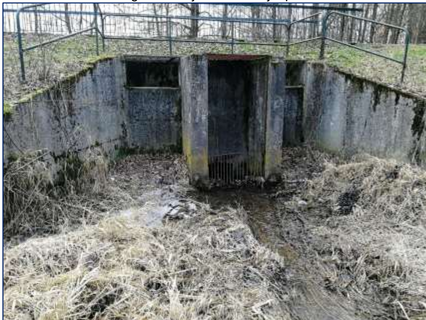
Obr.č.3 Pohled na regulační objekt a havarijní přeliv
