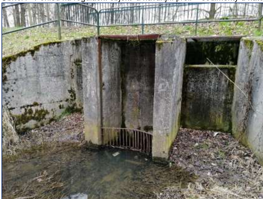
Obr.č.4 Pohled na regulační objekt a havarijní přeli - sedimenty u nátokového objektu
